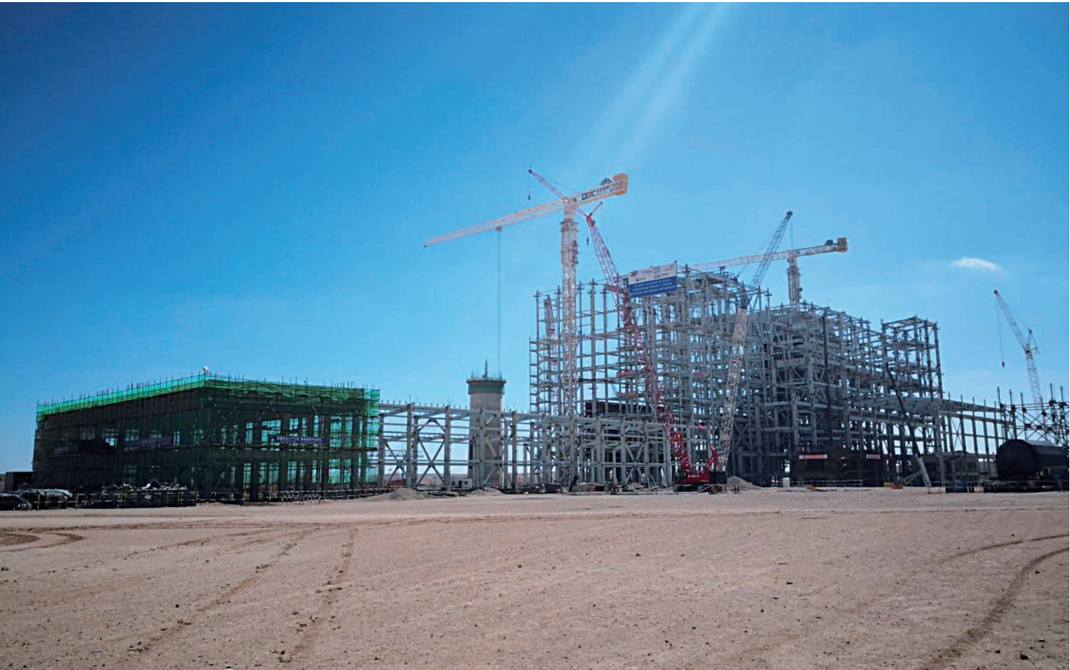
▽ 项目主厂房钢结构吊装（案例 3） Hoisting of the main workshop's steel structures (Case 3)
