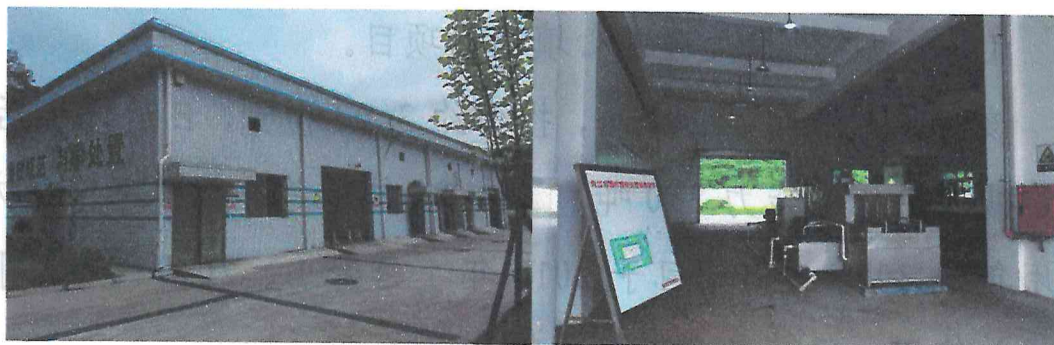
图 2-8 医疗废物集中处置设施项目
